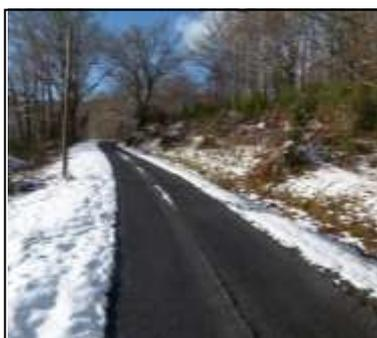
Revêtement bicouche et une dépose de gravitons en surface sur la route de La Brousse.
