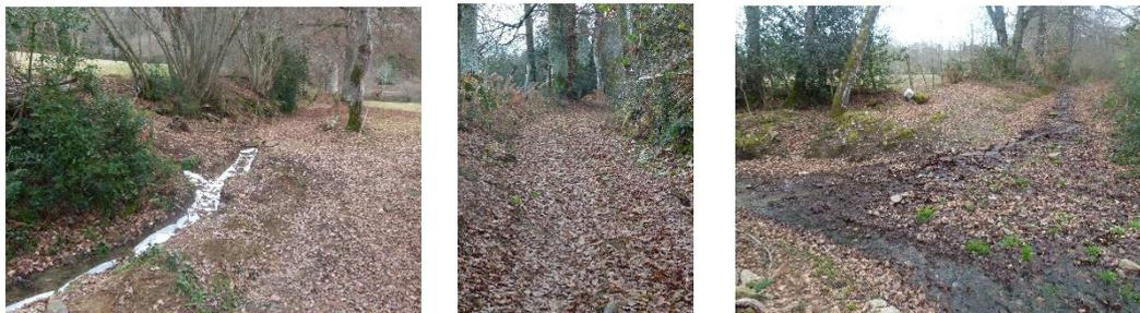
Réalisation d'une tranchée par l'entreprise MAGOUTIER de Saint-Yrieix-la-Montagne. Clichés : la tranchée creusée, la pose de tuyaux avec drainage, la dépose de cailloux par-dessus.
